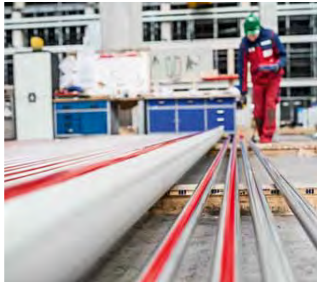
Blick in das Zentrallager für Rohre Beucha/Leipzig.
